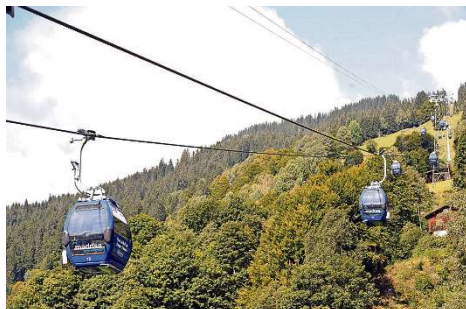
Die Klosters-Madrisa Bergbahnen wollen unter anderem in eine neue Sechser-Sesselbahn investieren. (FOTO NADJA SIMMEN)
